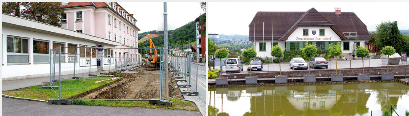
Die Bauarbeiten für die neue Weizer Ortsdurchfahrt wurde im Frühjahr 2016 gestartet, in Krottendorf gibt es weiterhin die Servicestelle.
