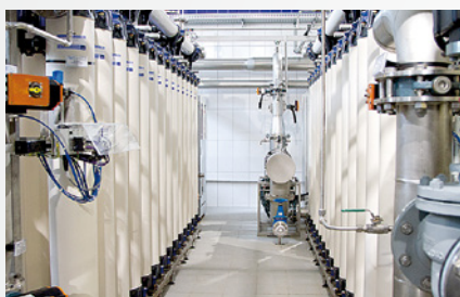
Zwei Millionen Euro wurden in die gesicherte Wasserversorgung investiert.
